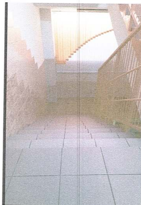
Фото № 10. Лестница внутри здания
