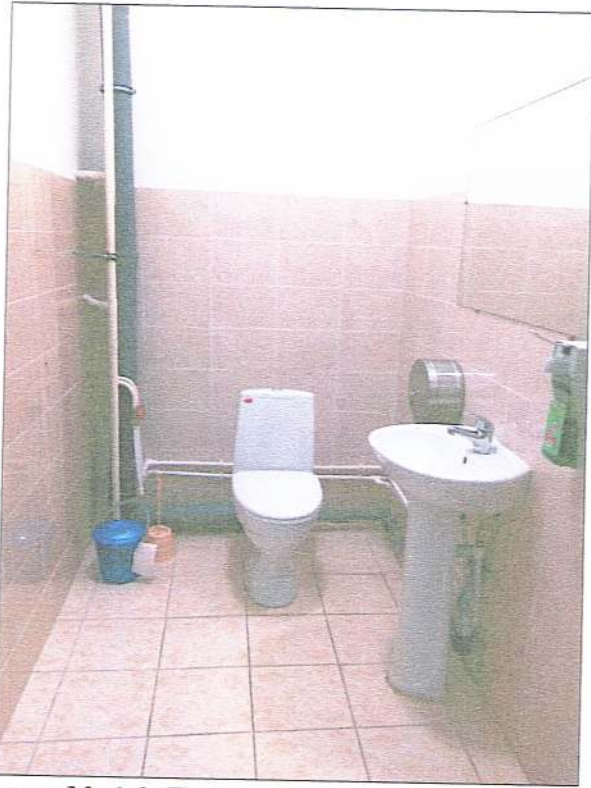
Фото № 16. Туалетная комната.
